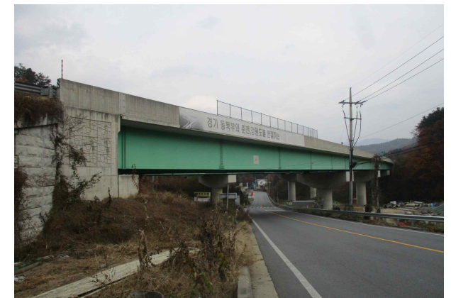
천안교(양양) 측면 전경
