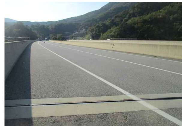
천안교(양양) 상부 전경
